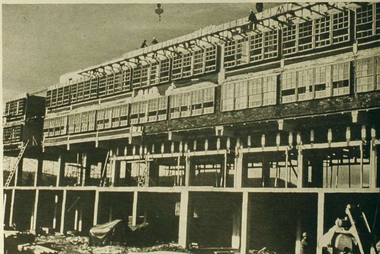
Construcción de la fachada de albanilería del internado de Izarra.
