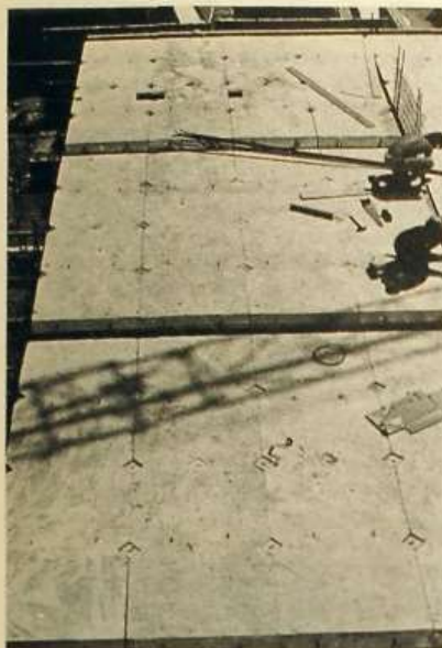
Los forjados prefabricados colocados sobre las células a la espera del vertido de hormigón.
