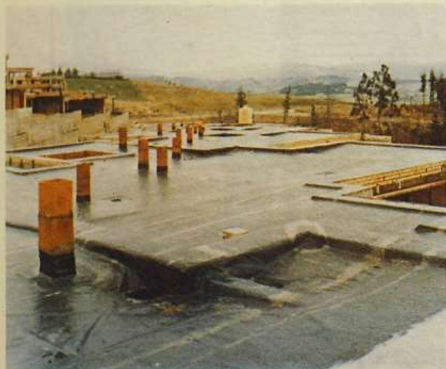
Chalets agrupados, contruidos en la Urbanización del "Club de Campo Sociedad Bilbaina", Vizcaya. Impermeabilización de cubiertas planas con láminas INDY.
