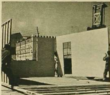
Montaje de las células tridimensionales con los paneles confeccionados a base de tableros de cartón-yeso.
