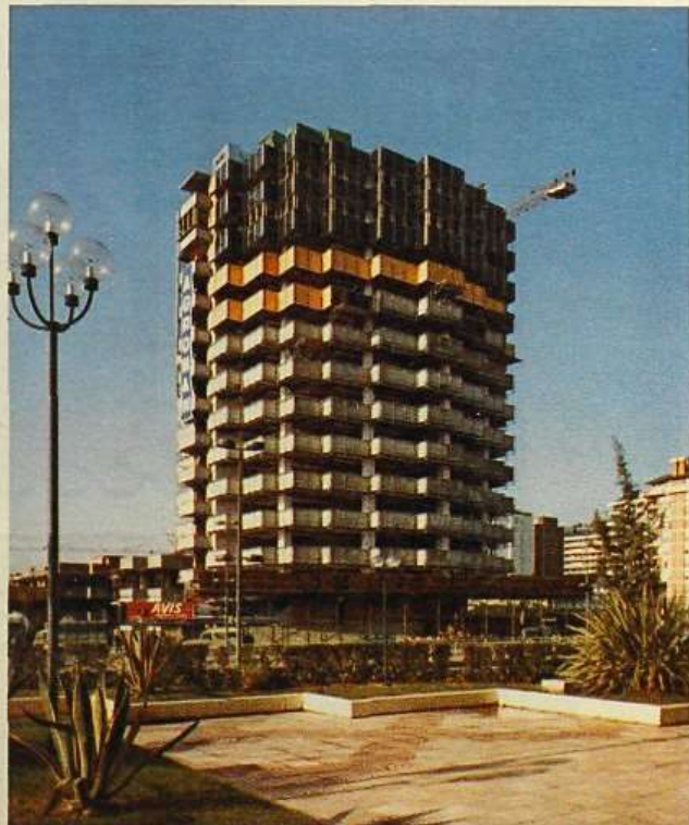
Edificio "Barcelona-2" construido por Agroman. Barrera de vapor en fachadas resuelta con 5.000 m 2 de butilo INDY.
