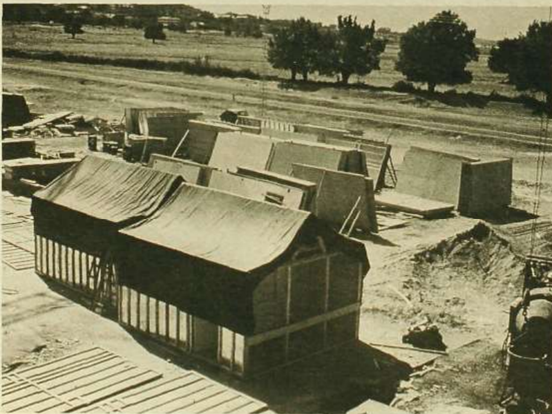
Taller a pie de obra para montaje de las células. En primer plano dos células protegidas frente a la lluvia.
