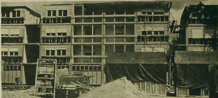
En la obra de Collado de Villalba gran parte de la superficie de fachada era previamente realizada en las células tridimensionales.
