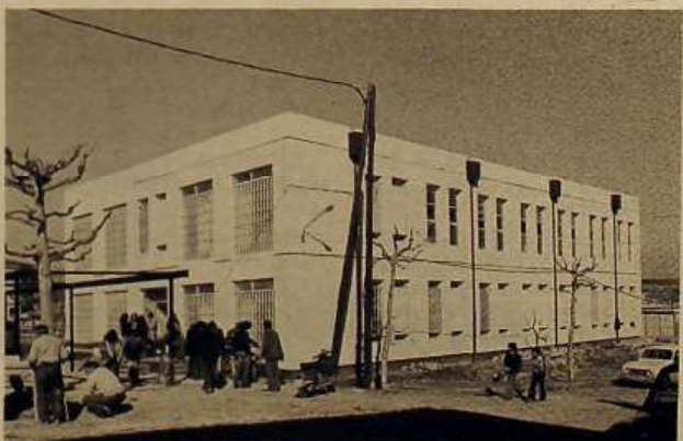
Aulario de 8 unidades en Sant Cugat del Vallés (Barcelona)
