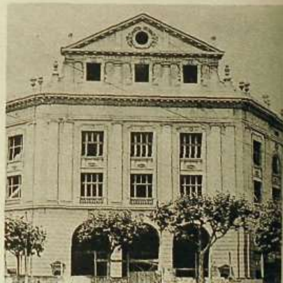
La fachada del Teatro-Circo Olympia. Un frontón (aparecido muy tarde en el proceso de proyectación) remata el edificio explicando la preponderancia de su valor urbano y del esquema sobre otras consideraciones más reales. A pesar de que han pasado casi 250 años no estamos muy lejos de algunos aspectos de la experiencia de la Place Vendôme.
