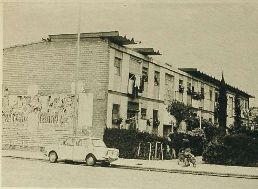
San Cosme: un producto típico de la arquitectura de la O.S.H. que el PERI remodela.
