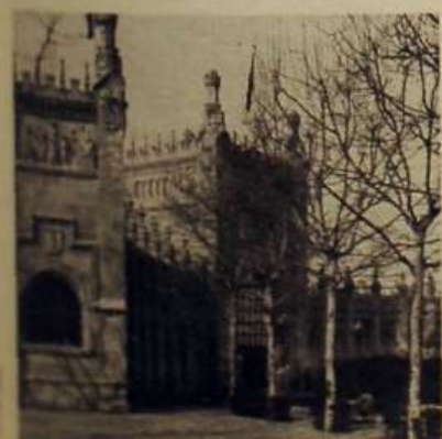
Palacio de las Diputaciones. E. Sagner, arquitecto.
