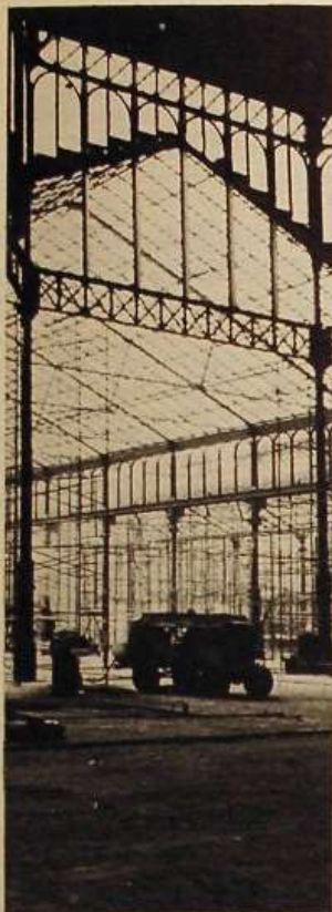
Vista durante el proceso de restauración, hoy prácticamente finalizado.
