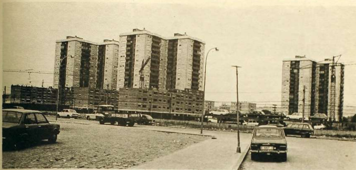
Viviendas en fase de terminación en el Polígono Gornal. Esperemos que sean las últimas.
