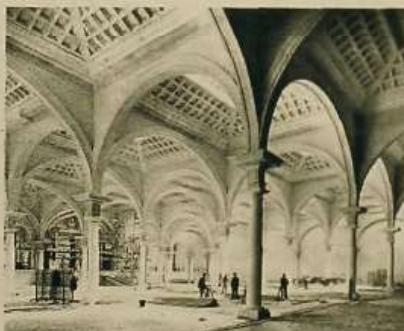
Últimas obras de acabado interior del actual palacio de Victoria Eugenia.
