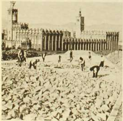
Inicio del alfirmado del paseo central. 1917.
