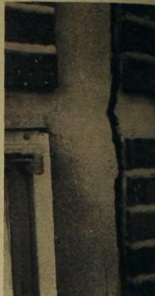
Rotura del soporte de hormigón armado de un muro por el efecto combinado de la propia retracción del hormigón del soporte y la dilatación por entumecimiento del muro.
