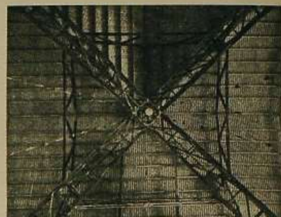
2. Armaduras diagonales en el cruce de las naves del Pabellón de Bélgica.
