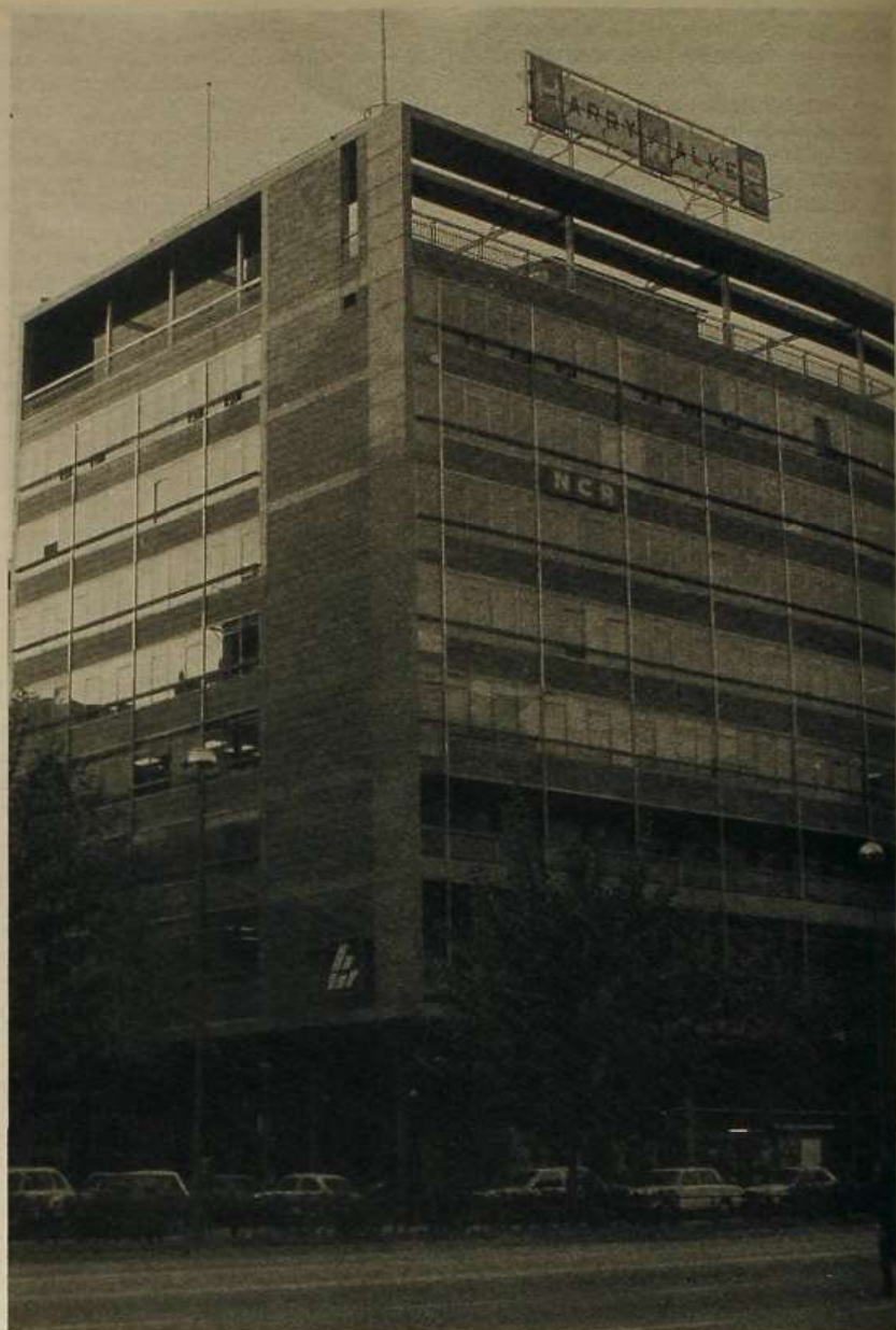
EDIFICIO HARRY WALKER (Barcelona). Prever las instalaciones desde el inicio del proyecto no es suficiente; también su coste puede modificar el producto acabado.
