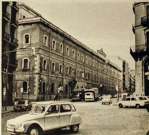
El cuartel de San Agustín. Su recuperación representa la obtención del mayor equipamiento posible.
