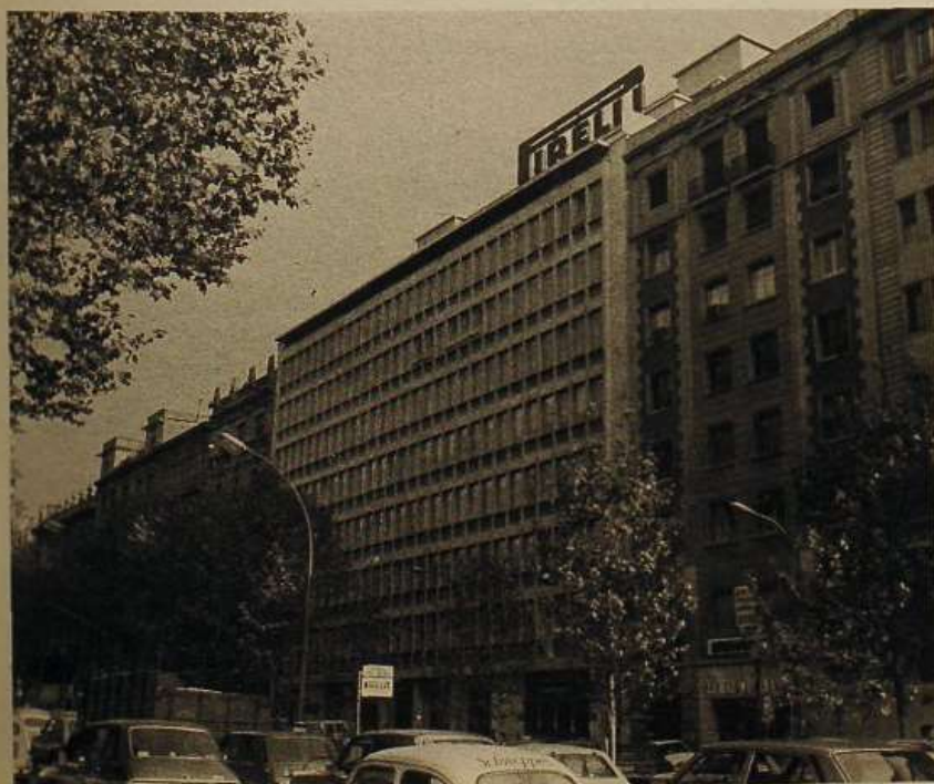
EDIFICIO PIRELLI (Barcelona). Uno de los primeros edificios climatizados. Aquí se pagó el aprendizaje.
