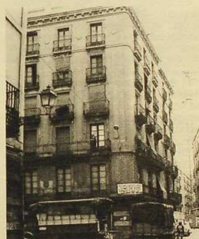
Edificio en la calle Comercio esquina Princesa que estuvo afectado por la apertura de la calle Méndez Núñez. Hoy, ocupado por el parvulario Puigmal, viviendas y «colectivos infantiles» del Ayuntamiento, es una cuña en el corazón del Plan Comarcal.
