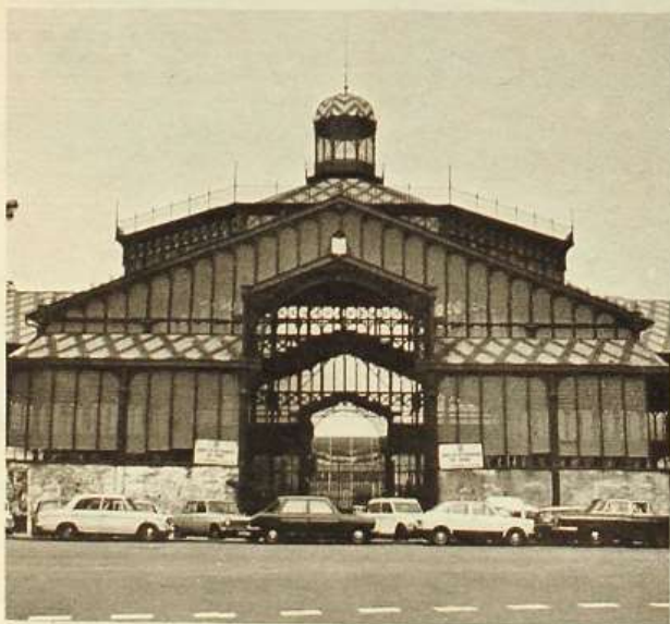
La reparación del Mercado del Born. Una operación de prestigio municipal seguramente no prioritaria para los vecinos.
