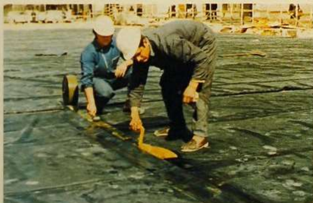
Detalle de empalmado en frío de las láminas. La facilidad de instalación es característica del caucho butílico INDY.
