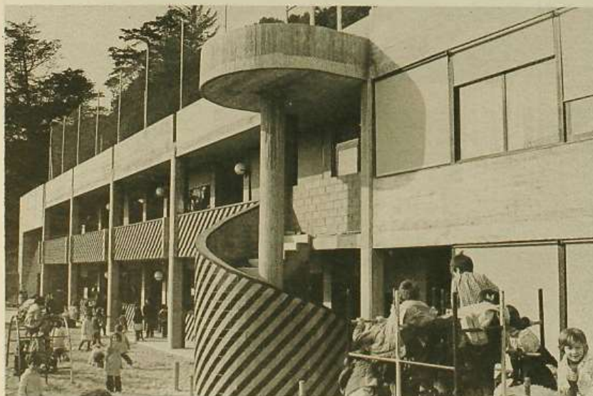
El parvulario, todavía inacabado, tiene acceso por una cara del bloque, a través de una galería y un pequeño patio de juegos.
