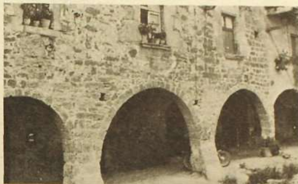
Los muros tradicionales cumplen a la vez las exigencias de aislamiento y resistencia a fuerza de espesor
