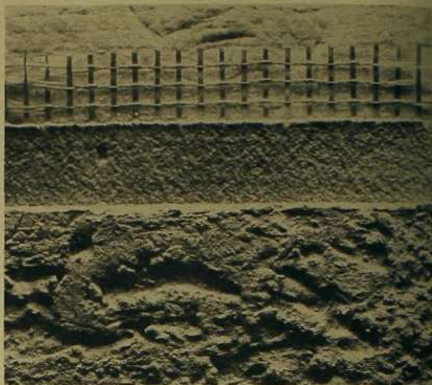
La necesidad de mejorar el aislamiento de los edificios ya construidos está introduciendo soluciones cada vez más sofisticadas como este estuco sobre malla de nylon y poliestireno
