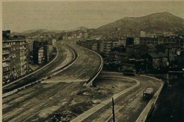
A veces sobre las viviendas y a veces a un metro o dos de distancia
