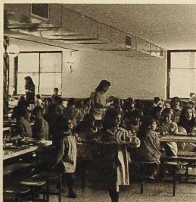
El aire caliente es conducido a través de tuberías vistas.
