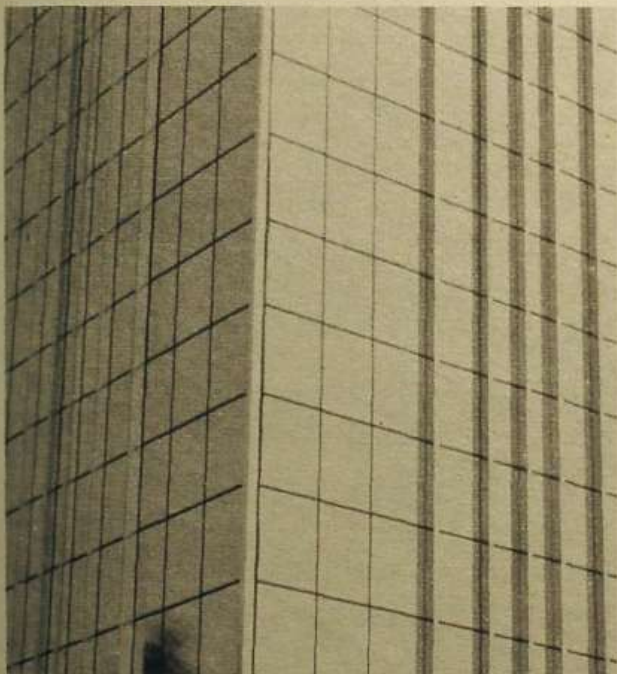
Los muros cortina plantean unas exigencias específicas
