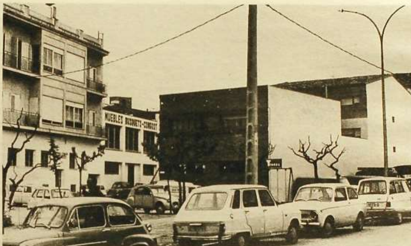
1. Plaza dels Servites de Banyoles. A pesar de las protestas de los vecinos por la invasión de la plaza con varios edificios, el Ayuntamiento construyó el Hogar del Jubilado que aparece en la fotografía.
