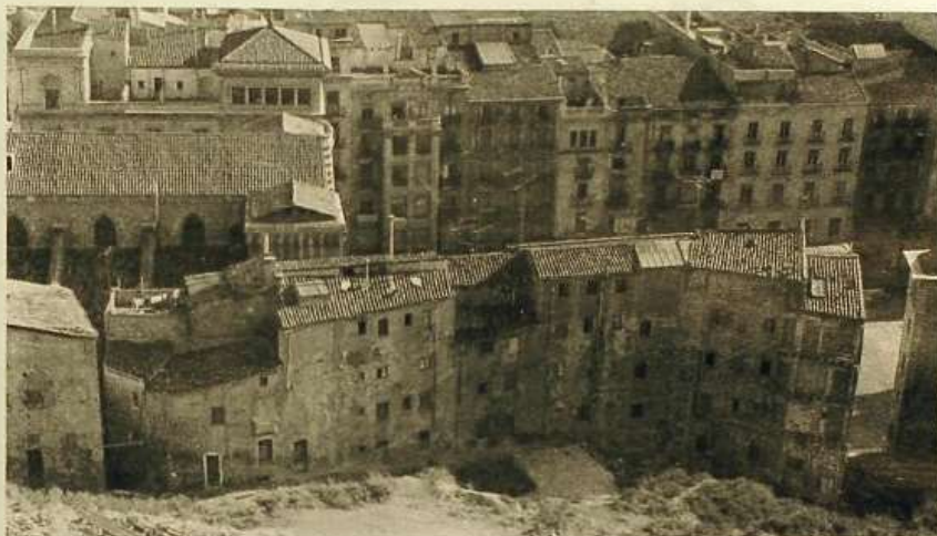
7. El derribo del antiguo Canyeret convierte a los edificios de la Plaça de Sant Joan y del Carrer Major en receptores directos del agua de escorrentía de la peana de la Seu. ¿Para cuándo la reordenación de la zona?
