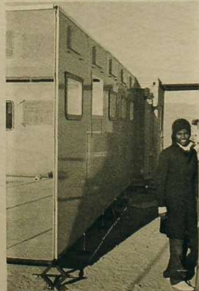
Ala lateral semiconstruida.
