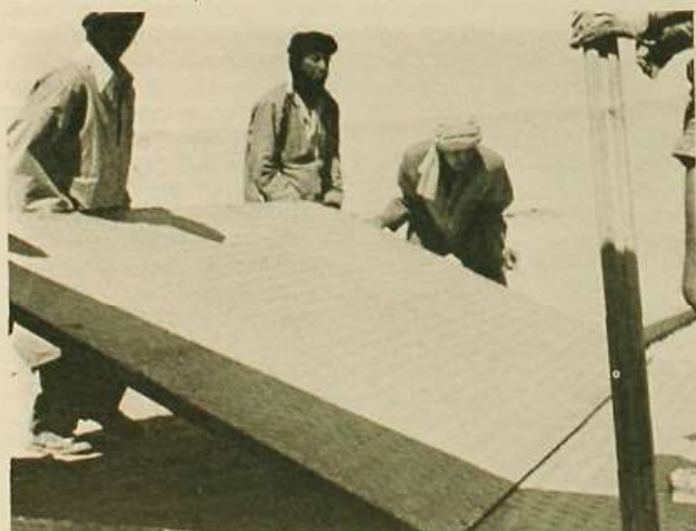
Colocación de una plancha de suelo en las alas laterales.
