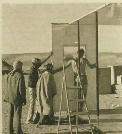
Colocación de paneles de cerramientos para la formación de las alas laterales.
