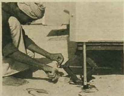
Nivelando el encuentro pared-suelo en una esquina del hospital con gato-soporte.
