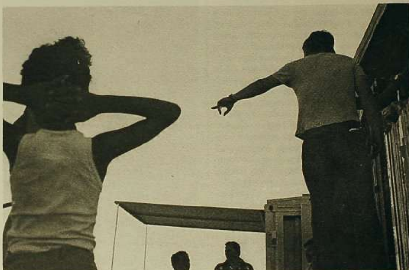
Los paneles se descargan del camión.
