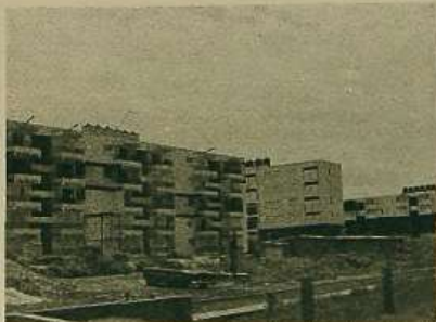
Escuela de Arquitectura a pie de obra en la urbanización Alamar (La Habana), construida con el Sistema Girón.
