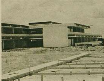
Centro de Enseñanza Primaria construido con el Sistema Girón.
