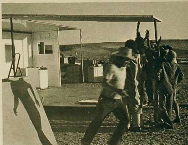
Construcción del techo del hospital.
