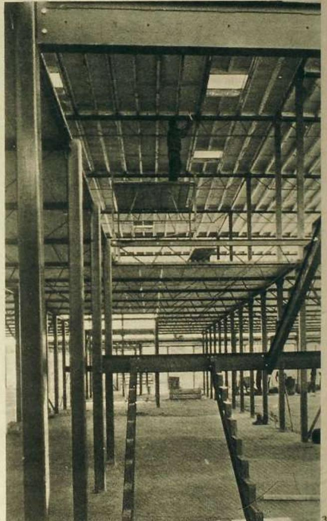
3 Fase de construcción mediante el sistema CLASP en Francia (Constructions Modulaire).
