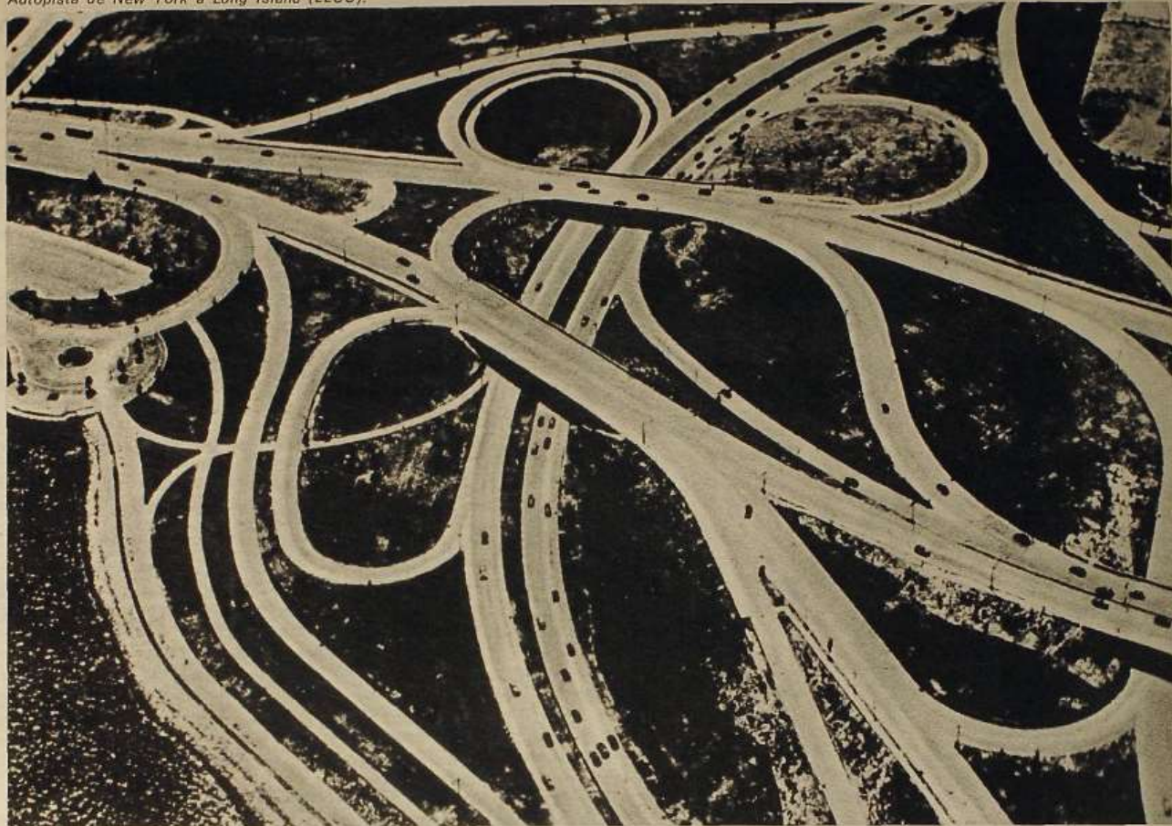
Autopista de New York a Long Island (EEUU).
