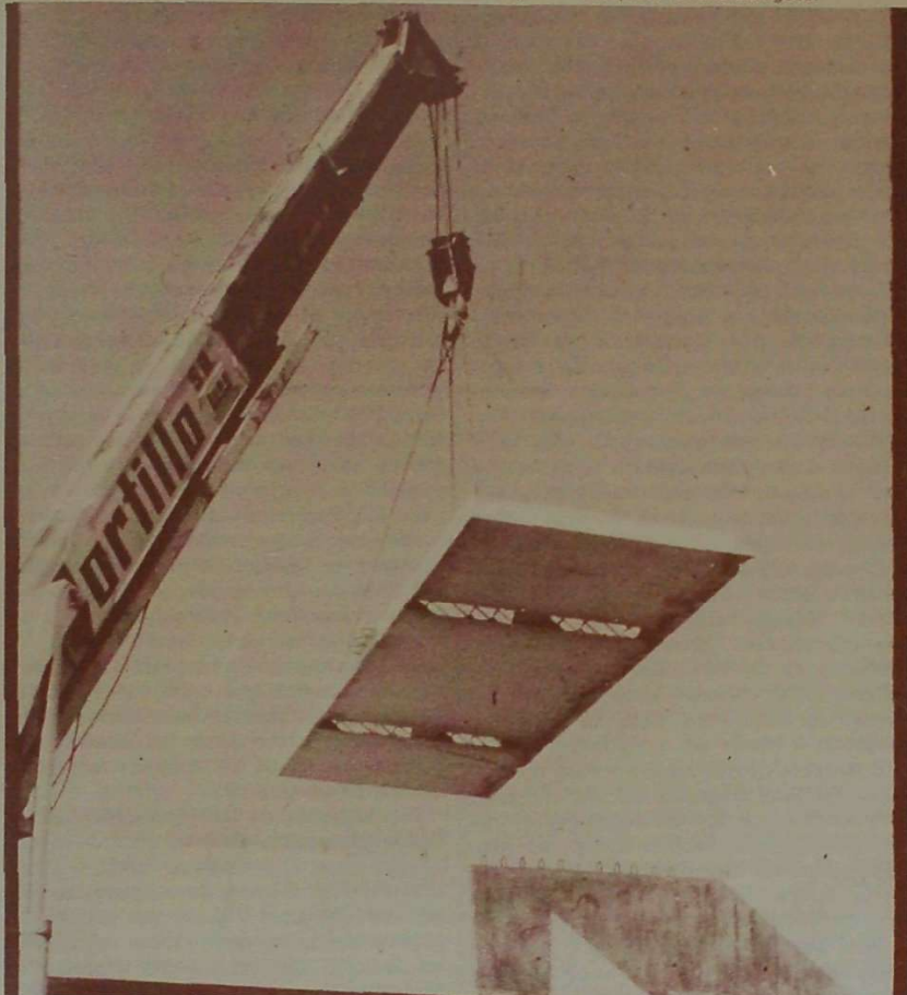
Perspectiva de montaje de elementos prefabricados. Paso superior autopista Bilbao-Zaragoza.
