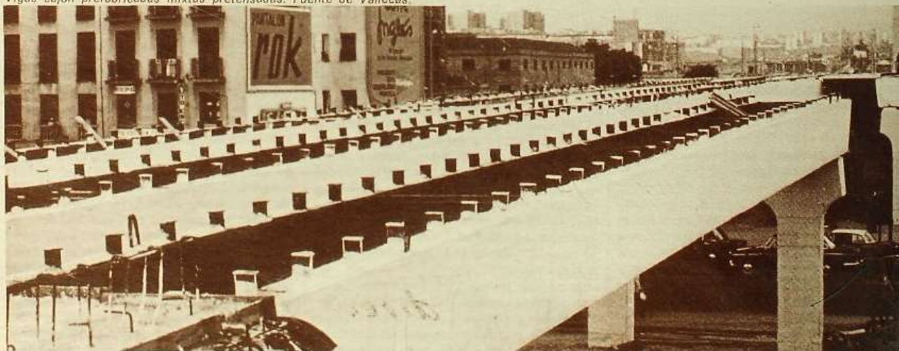
Vigas cajón prefabricadas mixtas pretensadas. Puente de Vallecas.
