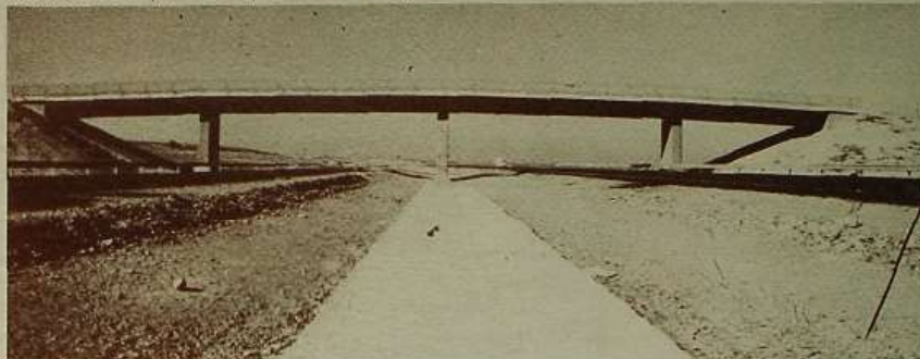
Impostas prefabricadas. Paso superior autopista Bilbao-Zaragoza.
