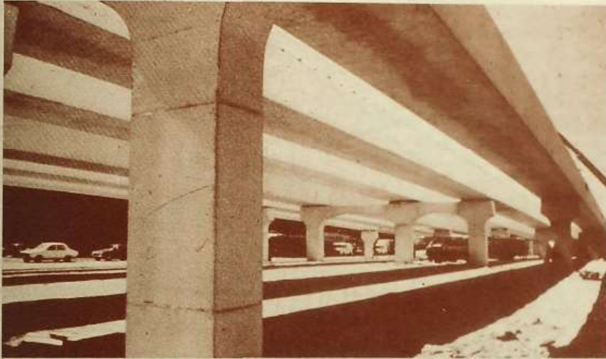
Interior de una viga cajón prefabricada mixta pretensada. Puente de Vallecas.
