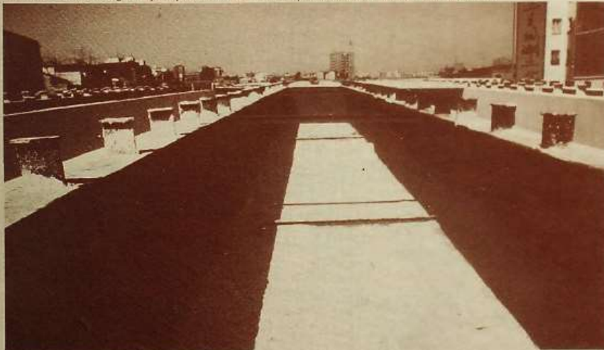
Pilas, vigas cajón y placas del tablero. Puente de Vallecas.
