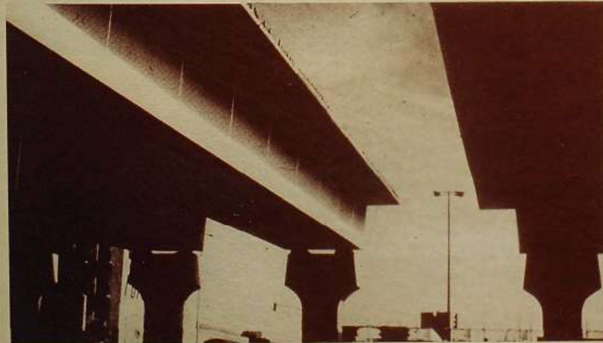
Pilas, vigas cajón y placas del tablero. Puente de Vallecas.
