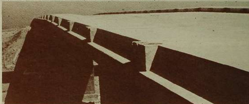
Alveolos y juntas, antes de hormigonar el tablero. Autopista Bilbao-Zaragoza.
