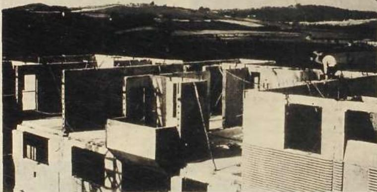
Vista general de un momento del montaje. Puede observarse cómo el panel de fachada se adelgaza en su parte alta, donde será cubierto por el panel superior.
