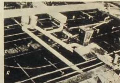
Colocación en un panel de forjado de las instalaciones sanitarias que van a quedar embebidas. Una cruceta metálica las fija para evitar su desplazamiento durante el vibrado.
