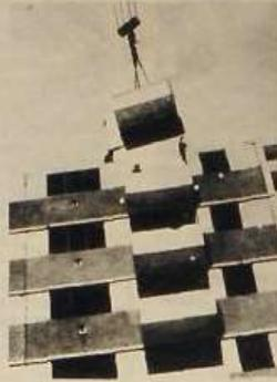
Elevación de un elemento especial de balcón. Este elemento tridimensional tiene un absurdo plano a 45° que rompe el ángulo de suelo y antepecho, probablemente para posibilitar el desencofrado.
