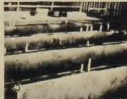
Moldeado de paneles portantes interiores en batería. Fue la primera vez que en España se utilizó el hormigonado vertical en serie. Este sistema, que permite una mayor rentabilidad, al hormigonarse y curarse varios paneles a la vez, sólo puede ser utilizado en paneles de separación interior y en forjados, ya que los paneles de fachada al llevar incorporado el sandwich aislante, precisan hormigonado horizontal.
