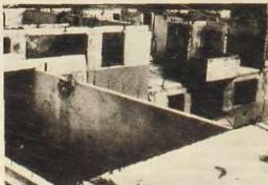
Montaje de los elementos verticales que forman la caja de escaleras. La falta de verticalidad en las tracciones de izado ha producido las roturas que pueden observarse.
