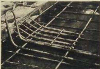
En esta armadura de borde de forjado puede observarse la preparación del diente de apoyo y del elemento de transporte.
