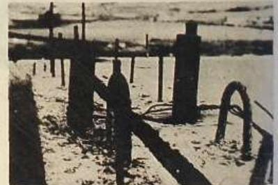
Parte superior de muros portantes en junta de dilatación. Se destacan los ganchos de transporte y los tubos de soporte provisional de cargas. Al fondo el Valle.
