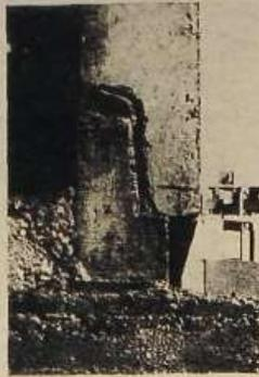
Una pieza especial de arranque se hormigona con el recocado de cimentación y da apoyo a un panel tipo de fachada.
