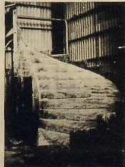
Fondo de molde de la escalera helicoidal de las viviendas T-72. Un diseño especial para estas viviendas en su versión CYT que demuestra que el sistema de prefabricación no determina la forma de los elementos constructivos.
