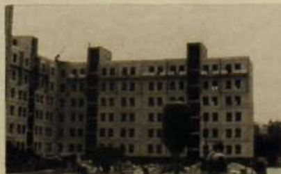
Edificios de Modulbeton, en Cerdanyola (Barcelona).
