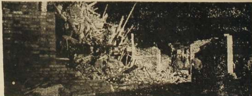
Vista parcial del edificio derrumbado. Las paredes exteriores de ladrillería se han hundido al tremendo empuje de los escombros. — (Fotos Pérez de Rozas)
