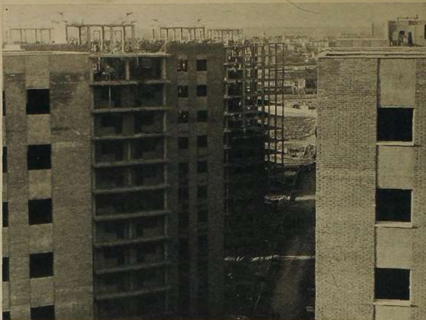
Obra que construye INHOR en Alcalá de Henares donde se están cerrando con obra vista y tabicando 30 viviendas por día.
