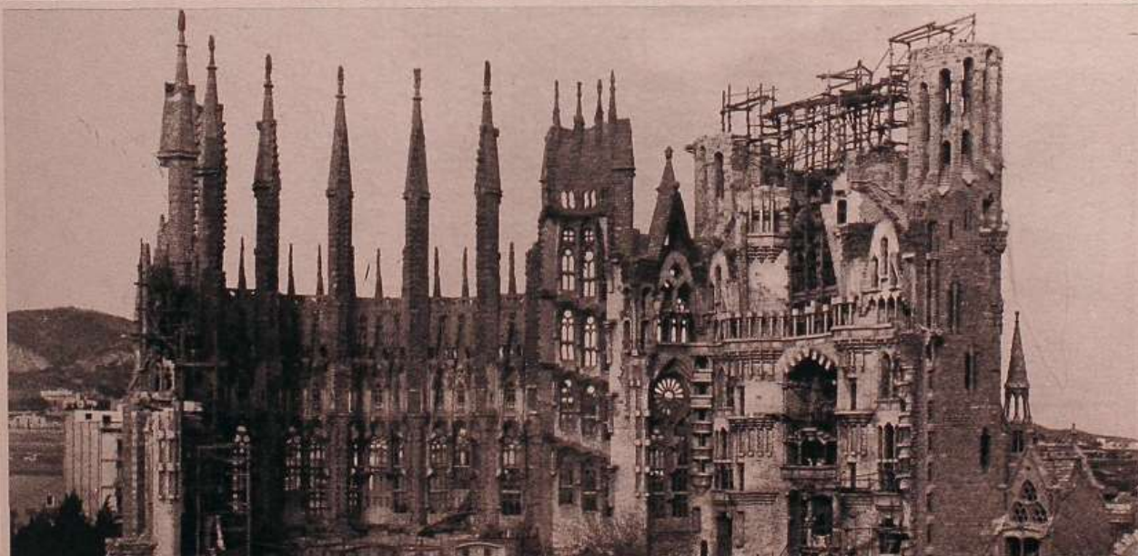
Estado de las obras en 1907 (foto Arxiu Mas).
