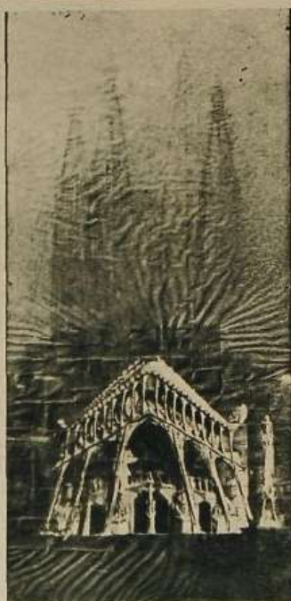
El «proyecto» de la fachada de la Pasión: dibujo de Gaudí realizado en 1917, que llevaba el maestro en el bolsillo cuando fue herido mortalmente por un tranvía en 1926. Este es todo el material gráfico de que disponían los sucesores para garantizar la fidelidad (foto Zerkowitx).
