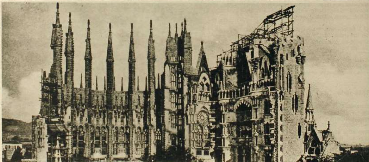
Estado de las obras poco después de iniciarse el siglo XX. Los promotores seguían silenciando el nombre del segundo arquitecto a su servicio (foto Arxiu González-Torán).
