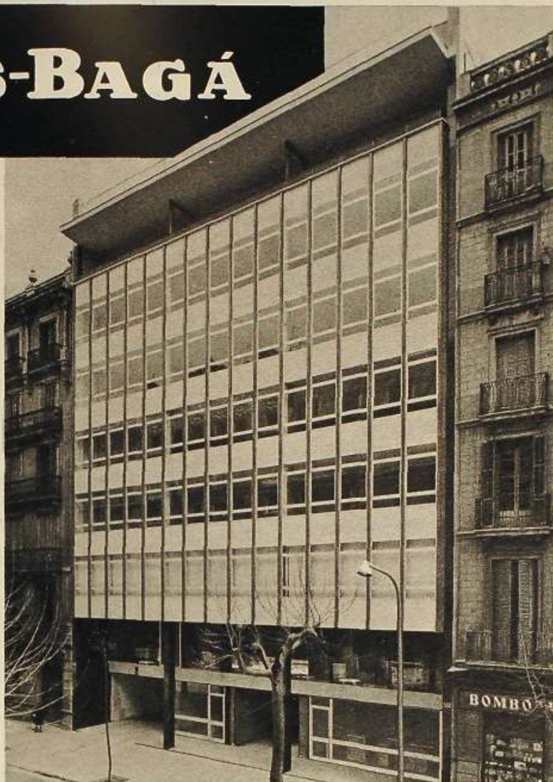
Edificio Mas Bagá - BARCELONA
