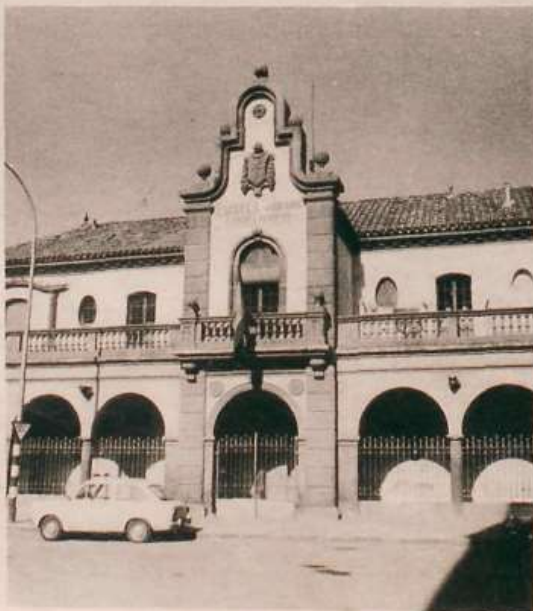
Escuela Jardín de los Campos Elíseos. Este tipo de edificación de los tiempos de la dictadura prorroverista se ha seriado hasta la saciedad para ubicar centros de enseñanza sin ninguna preocupación por su entorno urbano.
