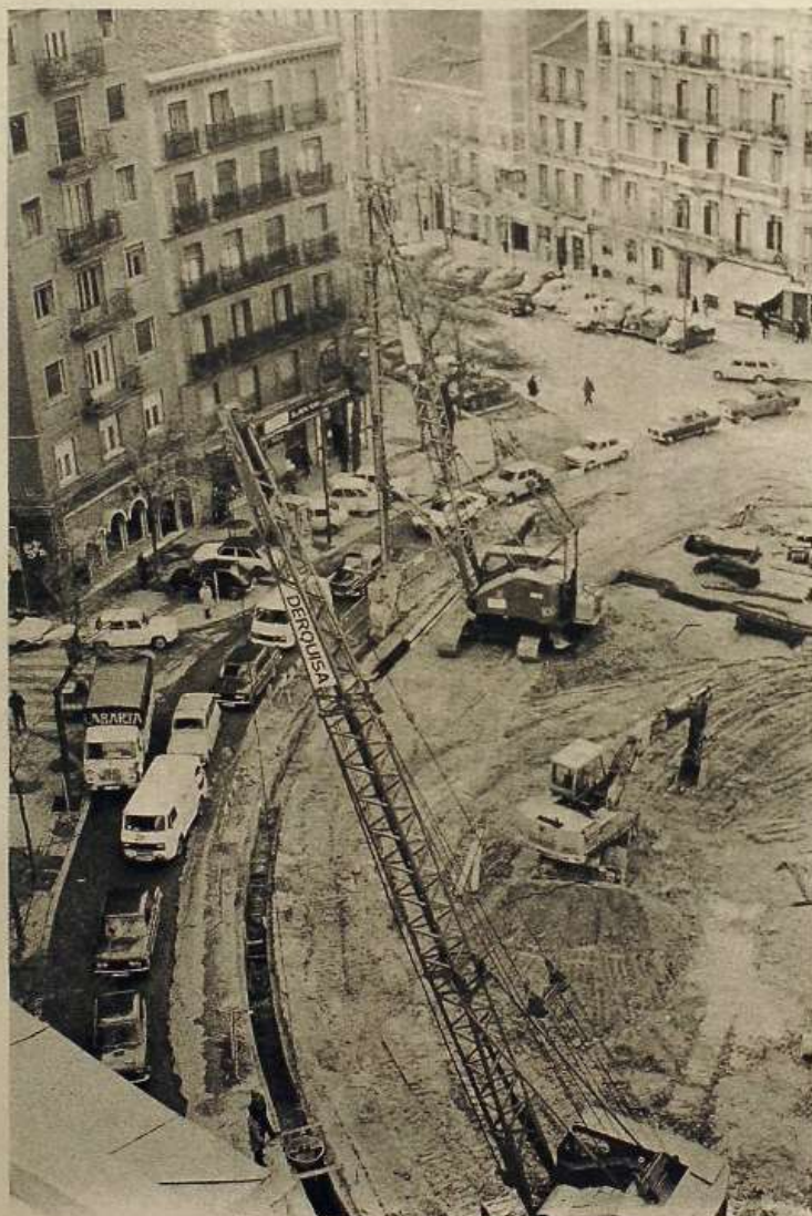
APARCAMIENTO SUBTERRANEO EN LA PLAZA DE OLAVIDE. (MADRID)
