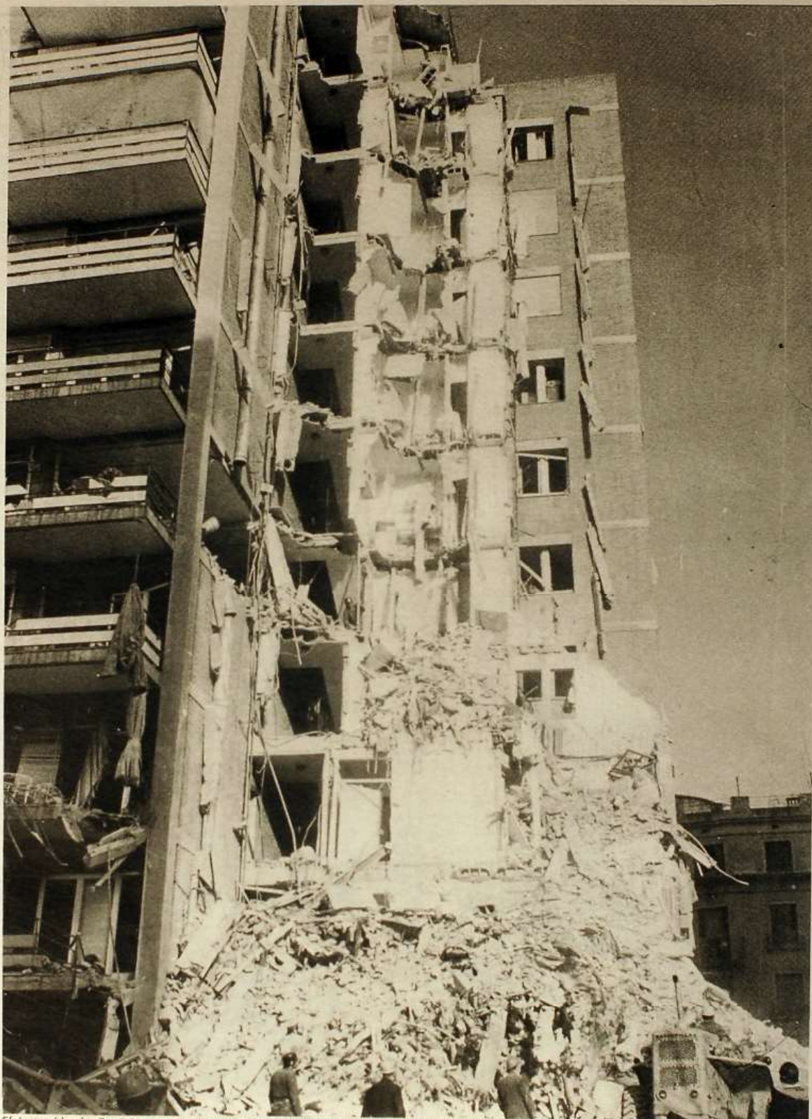
El Inmueble de Capitán Arenas después de la explosión (FOTO EUROPA PRESS)
