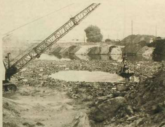
Extracción de áridos en las márgenes del río: se calcula que sólo en 1971 se extrajeron unos dos millones de metros cúbicos de grava.
