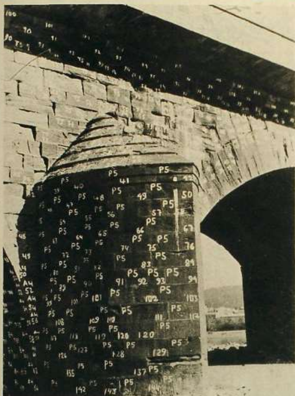
La pretensión de desmontar el puente, numerando sus sillares para su posterior traslado, se demostró inviable; después de la primera voladura, todos los sillares quedaron desmenuzados e irrecuperables.
