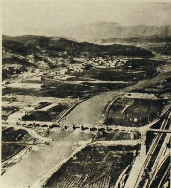
El segundo derrumbamiento, a finales de diciembre de 1971, tras el cual el MOP decidió la demolición total del puente.
