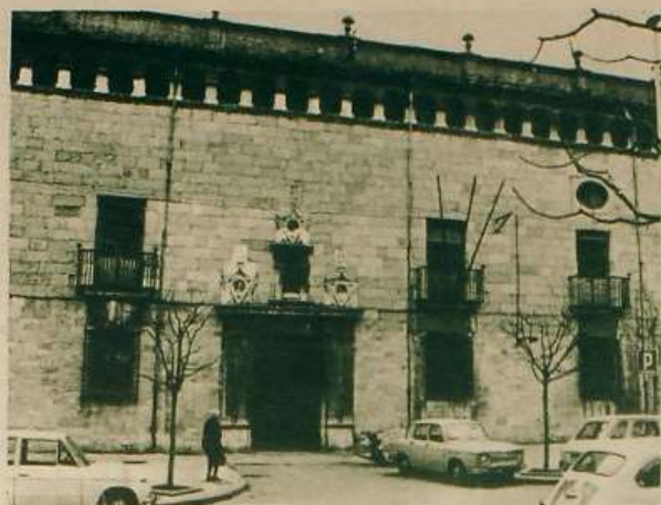
El Hospital de Santa Caterina, futura sede de la Diputación.
