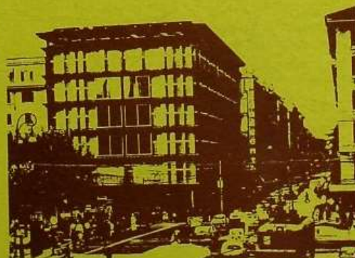
Grandes almacenes «La Rinascente». Roma. Arquitectos: Franco Albini y Franca Helg.
