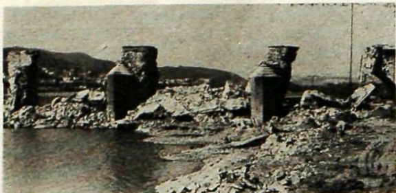
El puente de Molins de Rei derrumbado.
