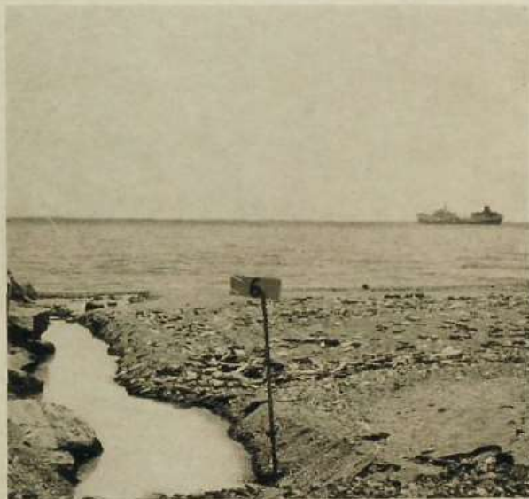
El petrolero descarga crudo para la fábrica de gas, mediante tubería sumergida.
