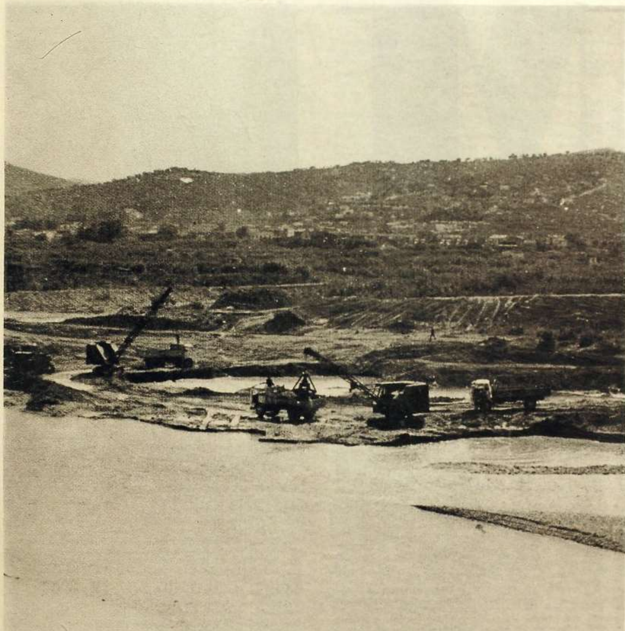
Extracción de áridos en el cauce del Llobregat, entre el puente de Molins de Rei y la riera de Cervelló.
