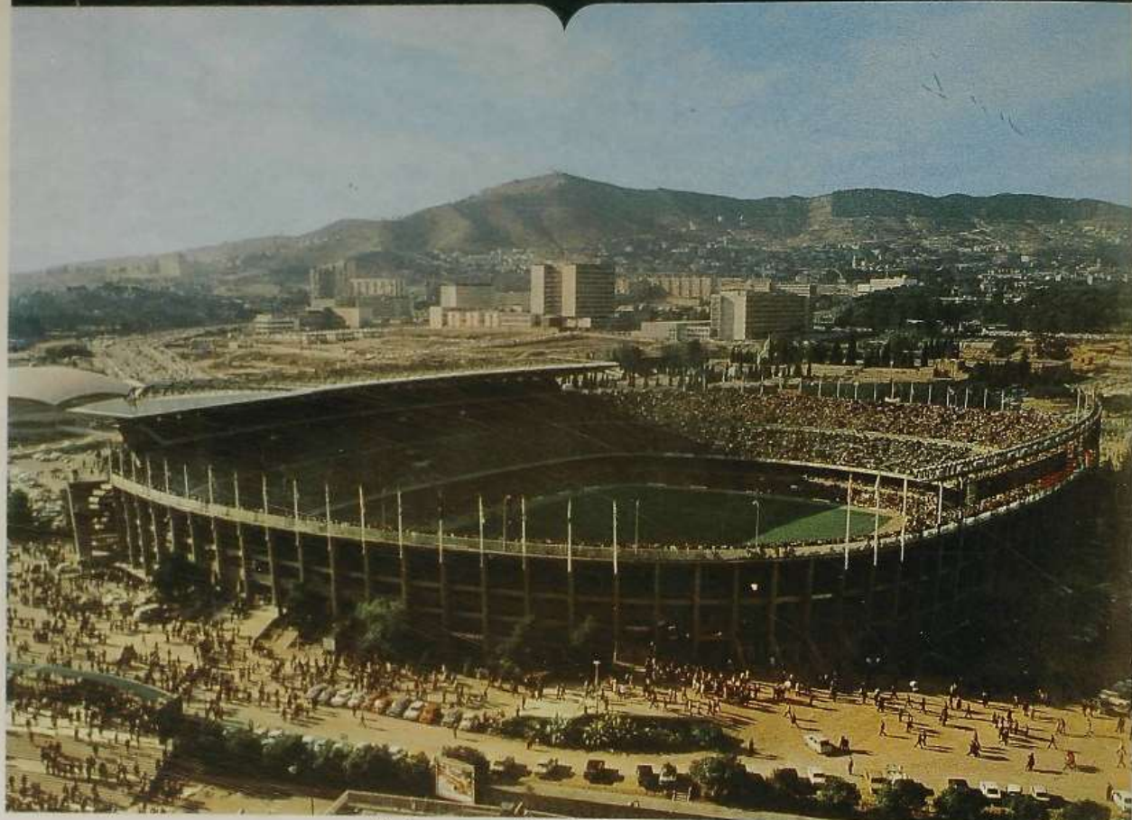
Reimpermeabilización de la cubierta de tribuna del «Nou Camp» Estadio del C.F. Barcelona
