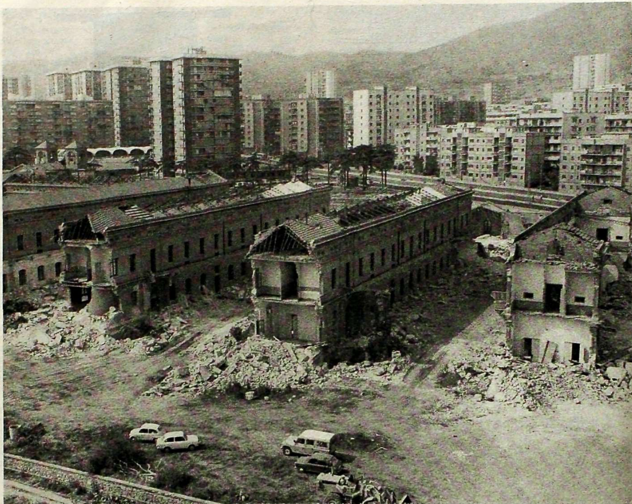
Obsérvese, detrás de los pabellones en demolición del Instituto Mental de la Santa Creu, La Guineueta, barrio edificado sobre antiguos terrenos del Hospital de San Pablo Fue la primera etapa (1961) de este plan de edificación de terrenos que hubiesen podido tener un fin público.
