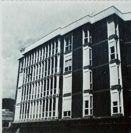
Viviendas en Castellar del Vallés
