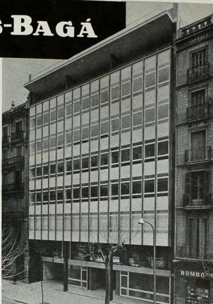
Edificio Mas Bagá - BARCELONA
