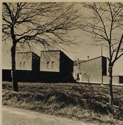
Viviendas colonia agrícola en Gimenells (Lérida)
