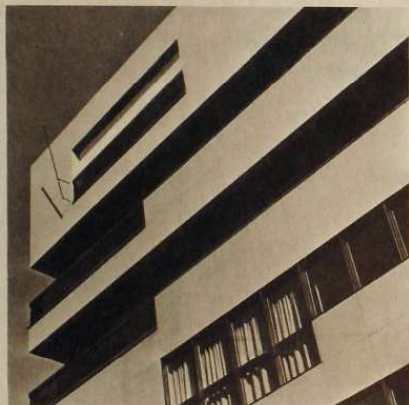
Edificio Juzgados en Vic
