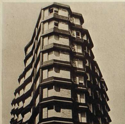
Vivienda plurifamiliar entre medianeras
