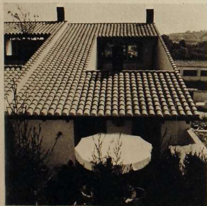
Edificio apartamentos en Ampurias
