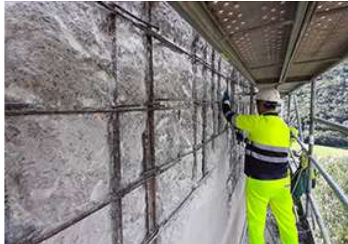
REPARACIÓ I REFORÇ DEL FORMIGÓ
