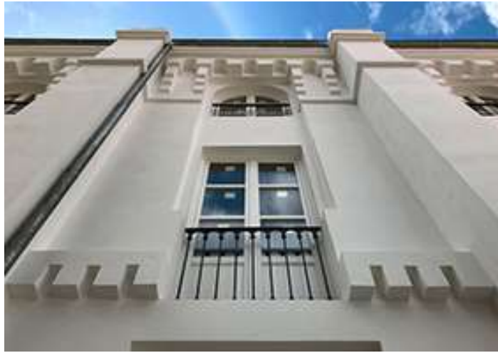
REVESTIMENTS DE CALÇ
